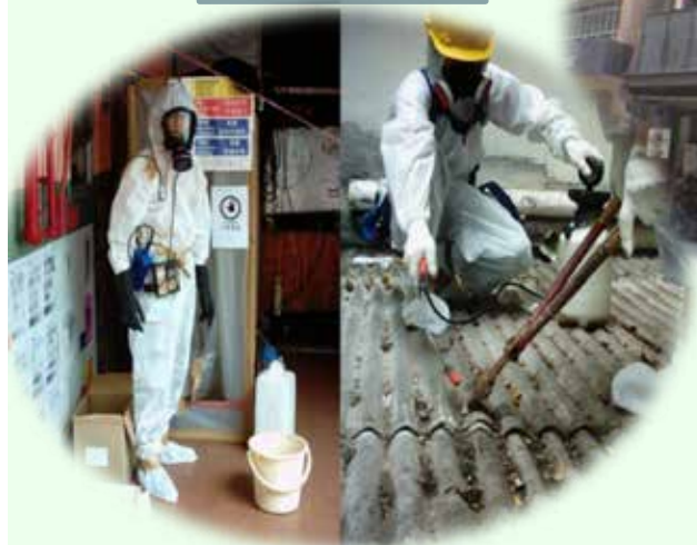
石棉檢查及清拆
