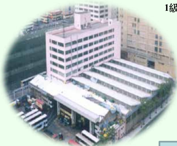
更換屋宇天面坑片及防水
