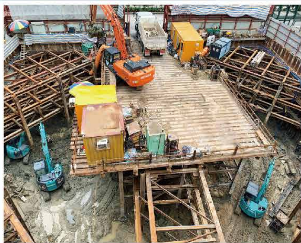
地盤平整、挖掘和側向支撐工程 Site Formation & ELS Works
