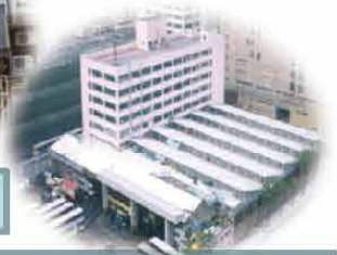
更換屋宇天面坑片及防水
