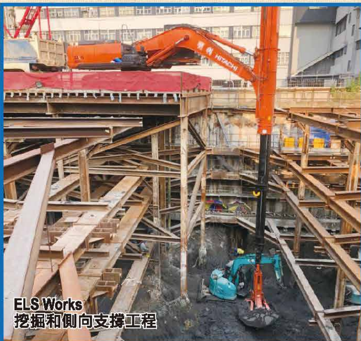
Site Formation & ELS Works 地盤平整、挖掘和側向支撐工程
