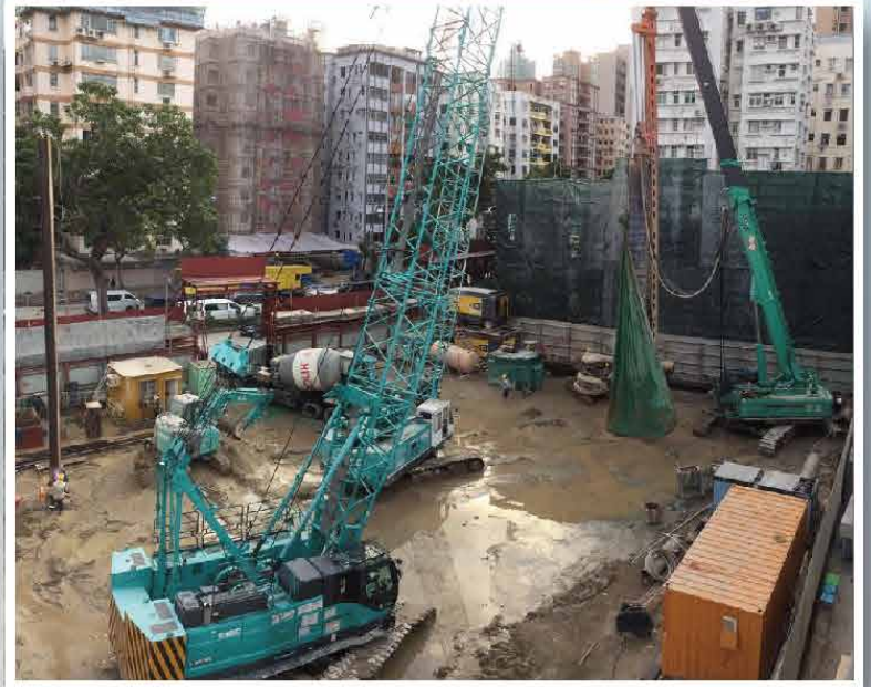
基礎工程 Foundation Works
