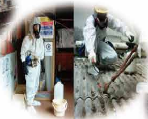
石棉檢查及清拆
