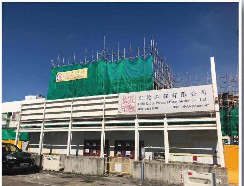
樓宇上蓋工程 Superstructure Works
