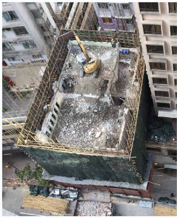
樓宇拆卸工程 Demolition Works
